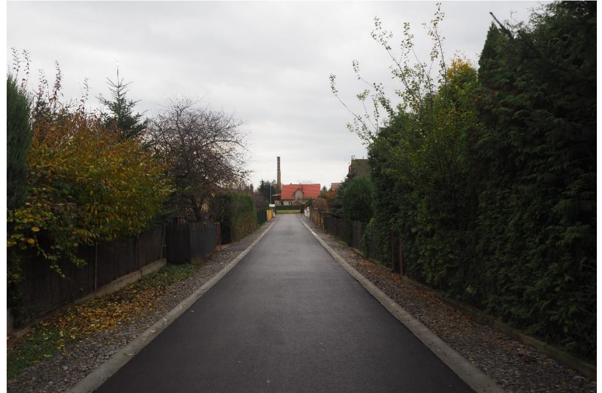
Przebudowa ul. Miłosza
