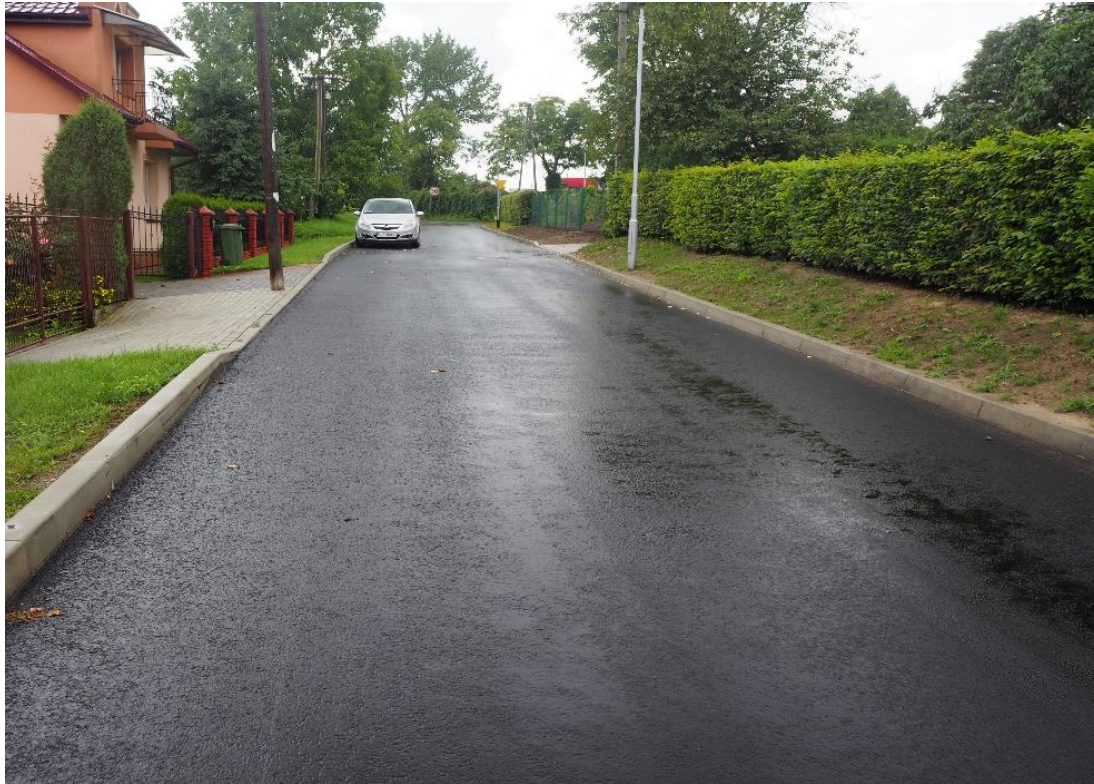
Przebudowa ul. Czechowskiego (II etap)
