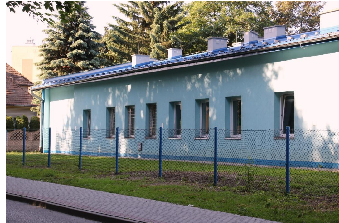
Modernizacja ogrodzenia stadionu miejskiego przy ul. Bandurskiego
