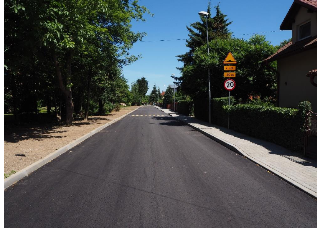
Przebudowa ul. Raszyńskiej
