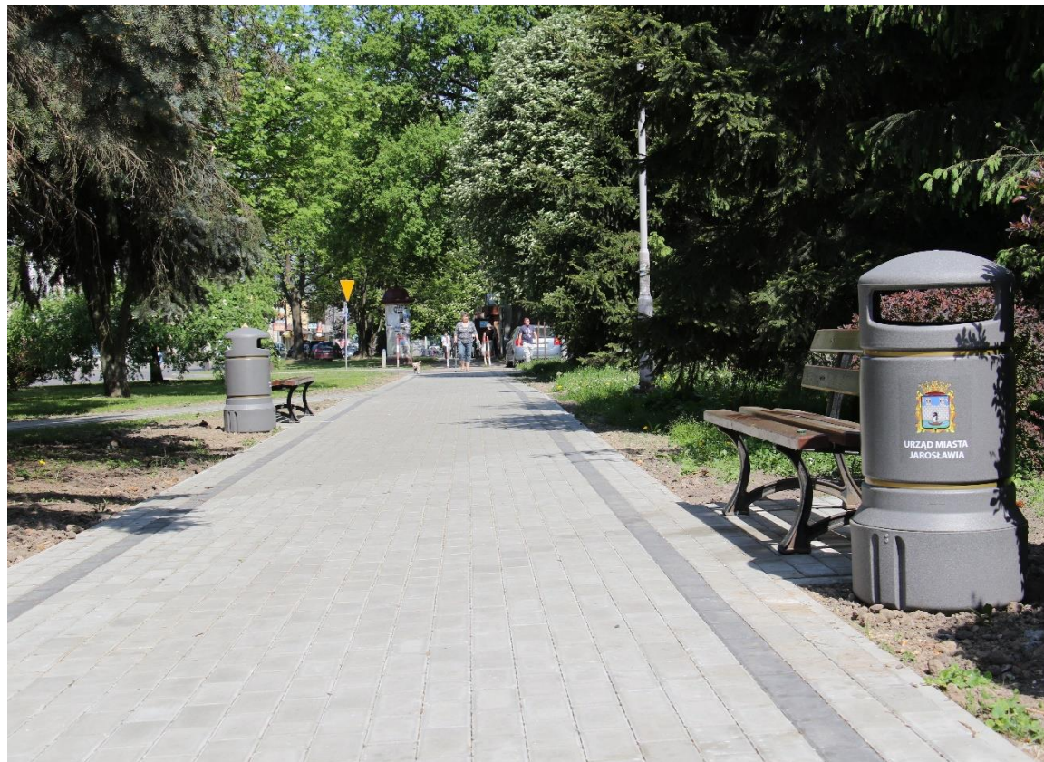
Modernizacja chodnika przy placu Inwalidów Wojennych
