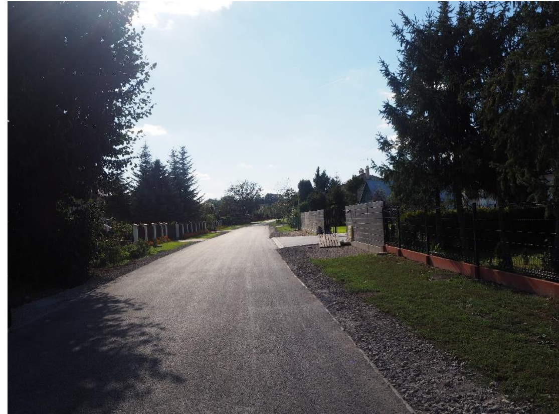
Przebudowa ul. Kruhel Pawłosiowski (II etap)
