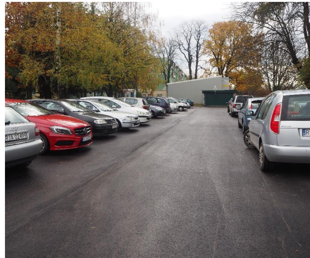
Przebudowa ul. Konfederackiej
