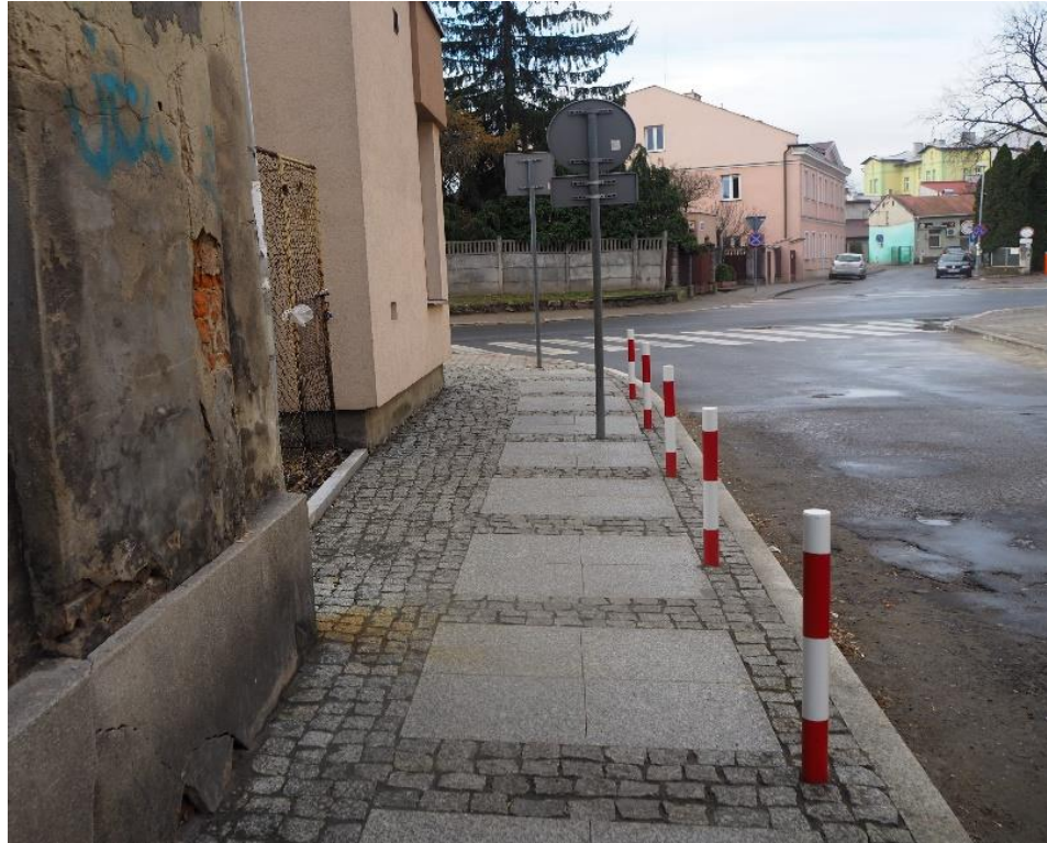
Przebudowa chodnika przy pl. Mickiewicza
