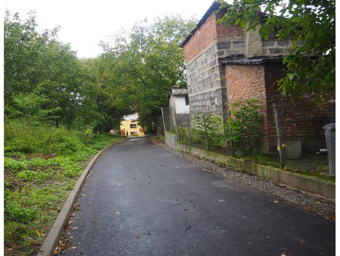
Przebudowa ul. Kruhel Pełkiński od nr 45–53A
