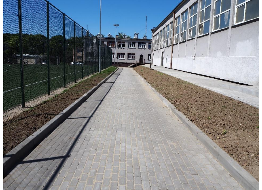
Utwardzenie terenu działek Szkoły Podstawowej nr 11 wraz z budową wjazdu od ul. Kraszewskiego
