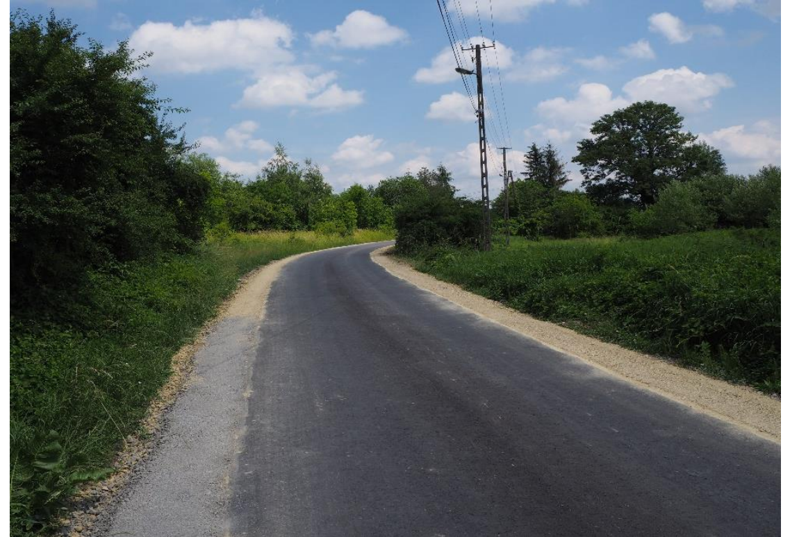
Przebudowa ul. Dojazdowej (II etap)
