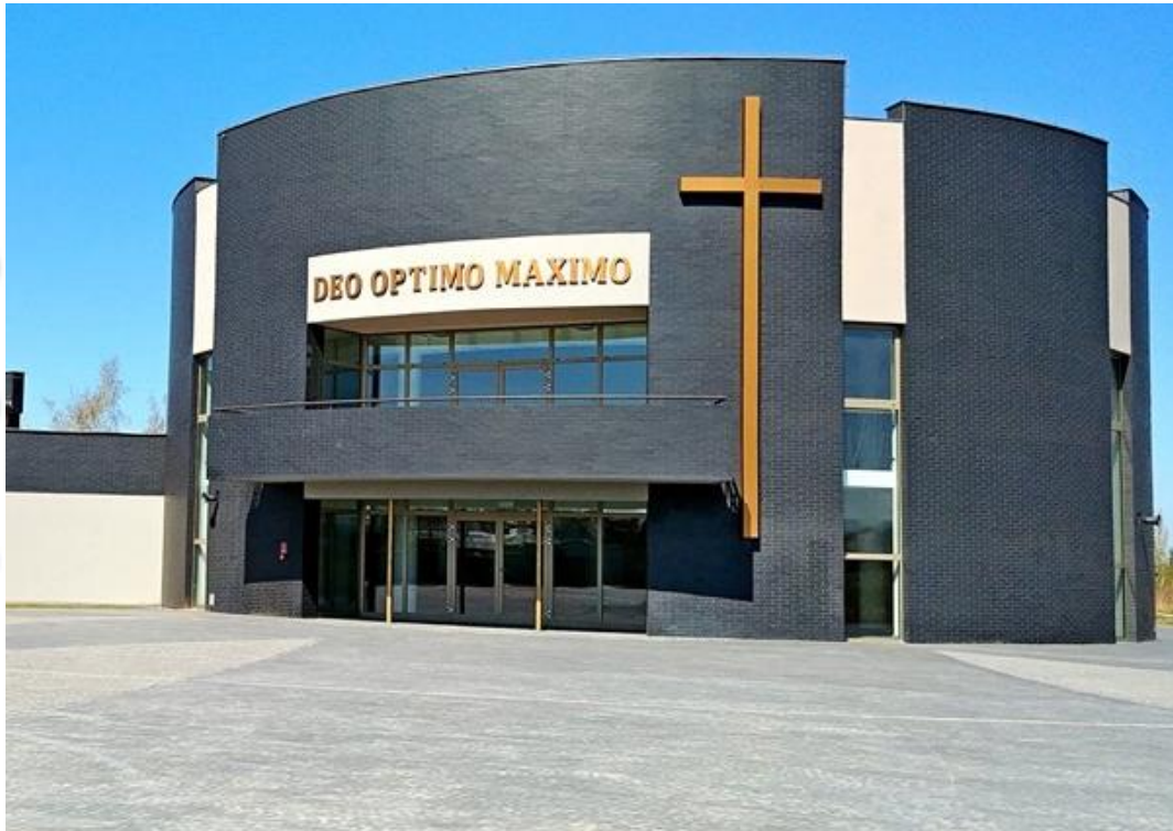
Budowa cmentarza komunalnego przy ul. Szczytniańskiej (III etap)
