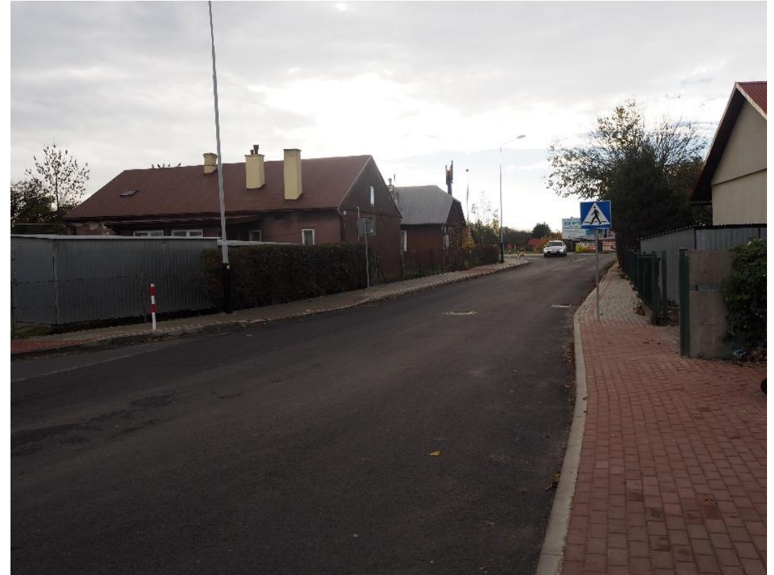
Przebudowa ul. Spółdzielczej
