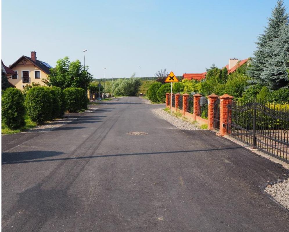
Przebudowa ul. Wiśniowej
