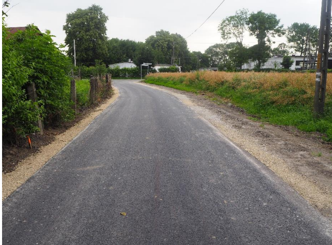
Przebudowa ul. Burmistrza Jerzego Matusza
